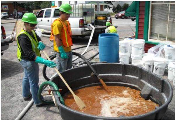
Figura 2.5- Preparazione della soluzione da iniettare
