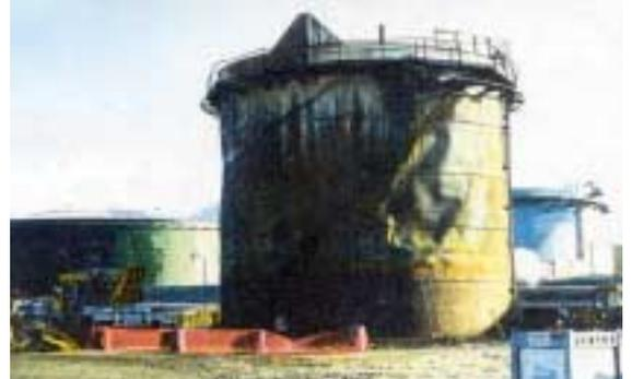
Environ 20 m<sup>3</sup> d'hydrocarbures s'écoulent, via le circuit des événements, sur le toit flottant du réservoir de récupération. Ils sont normalement récupérés par le réseau de drainage des eaux pluviales et renvoyés au niveau du sol, au pied du bac, où se forme une grande flaque. Un nuage de vapeur d'essence se forme à partir des flaques de produit situées à la fois sur le toit du bac et au pied de celui-ci. Le nuage dérive jusqu'à la route passant à 60 m du réservoir.
