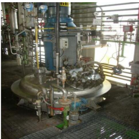
Le 27 janvier à 13 h, une hydrogénation se termine dans le réacteur R404 (Cette formule de fabrication est relativement peu fréquente, voire rare puisque la dernière campagne remonte à plus de 6 ans). Six lavages à l'eau sont effectués notamment pour éliminer les traces du catalyseur de la réaction (Palladium) ainsi que 2 lavages au méthanol à chaud (30°C) pour éliminer les traces de composés organiques contaminant encore le réacteur.
