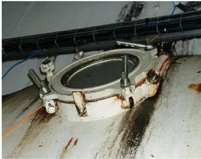
Les tanks de fermentation utilisés sur le site sont en acier revêtu, ils sont équipés en partie haute d'un hublot en plexiglas permettant un contrôle visuel de la bière en fermentation. Ils ont un diamètre de 3 mètres et une longueur de 17 mètres, soit un volume de 120 m<sup>3</sup>, et sont en position horizontale.
