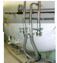
Les tanks, lors des phases de fermentation, sont soumis à des pressions relatives de 500 à 700 millibars. Le gaz carbonique est évacué par simple surpression. Les installations ne sont donc pas soumises aux réglementations sur les appareils à pression, notamment le décret n° 99-1046 du 13 décembre 1999 relatif aux équipements sous pression, l'arrêté du 15 mars 2000 relatif à leur exploitation et l'arrêté ministériel du 5 janvier 1962 réglementant les canalisations d'usine.
